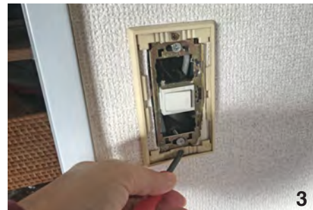
3 プラスチックの枠を固定している上下のビスをプラスドライバーで外します。
