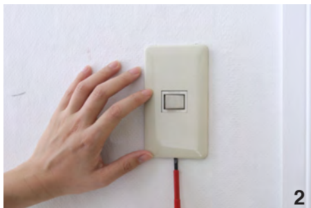
2 プレートと壁の間、下部中央に薄い隙間があるので、そこにマイナスドライバーを差し込み、表面のプレートを手前に持ち上げてはけません。
