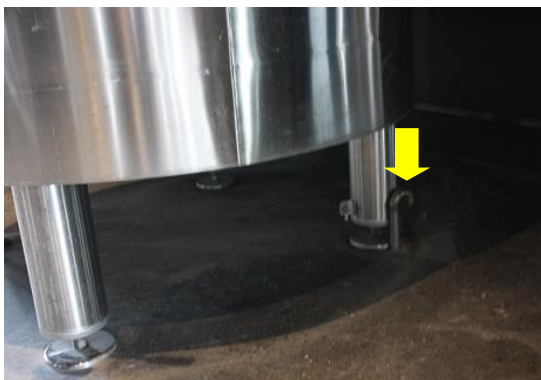
電気が貯まりやすいステンレスタンクには電気を逃がすアースが取り付けられています。全ての設備、構造にはエルヴェ独特の拘りが行き届いています
