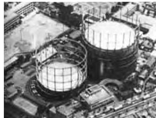
1974年頃のガス貯蔵設備 / 有水式ホルダー
