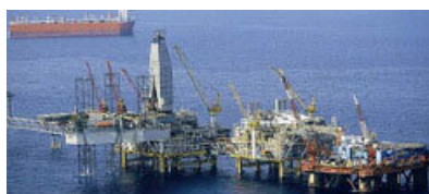
Darwin LNG Project
