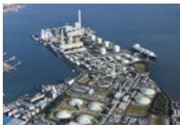
Negishi LNG Terminal
