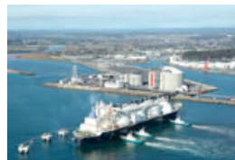
Hitachi LNG Terminal
