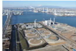
Ohgishima LNG Terminal
