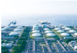
Sodegaura LNG Terminal
