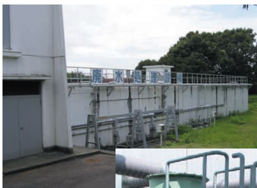
フジヤマ工場廃水処理設備
