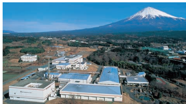
フジヤマ工場
