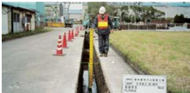
燃料転換のため約2,000mの都市ガス配管を敷設
