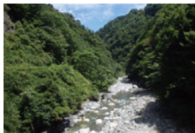
水力発電所の集水域の様子
