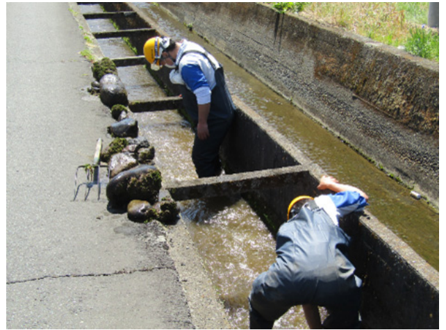
水路のゴミや草取り、土砂・藻の除去の様子
