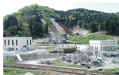
新姫川第六発電所（2022年送電開始）
