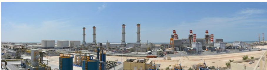
< 発電および海水淡水化プラント >
