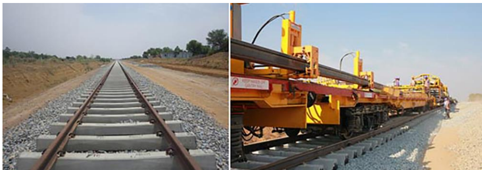
軌道敷設工事風景
