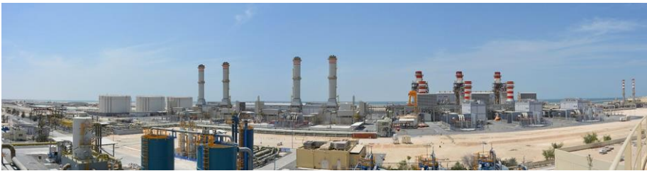
< 発電および海水淡水化プラント >
