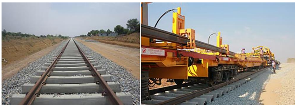
軌道敷設工事風景
