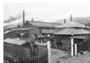
神戸製鋼所、創業当時の正門
