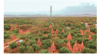
通信タワー(ミャンマー)
