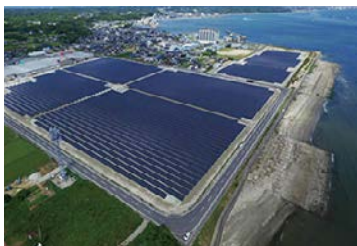
太陽光発電所 (日本/知多美浜 太陽光発電所)
