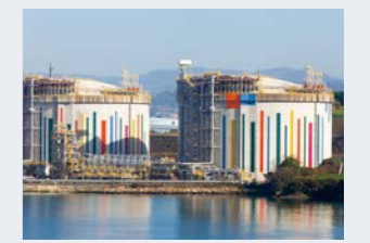
ムガルドスLNG受入基地(スペイン)
