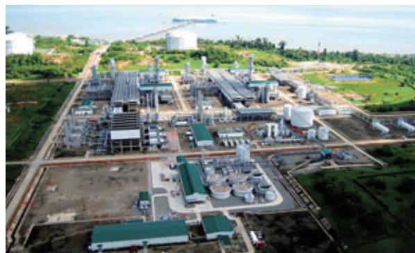
インドネシア タンゲーLNG基地
