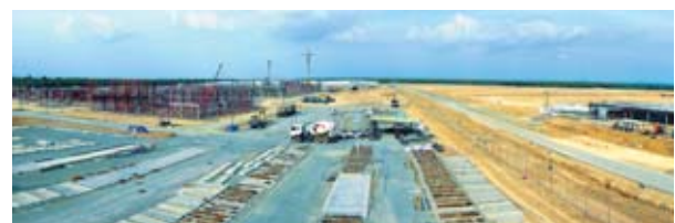
ベトナム・ Rondouk 工業団地の建設作業
