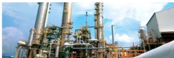
KMI社 メタノール製造工場
