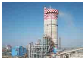
ファティマファーターライザー社 肥料プラント
