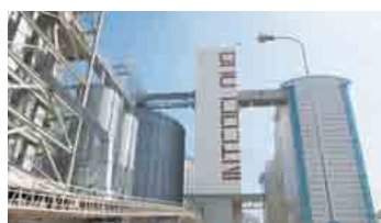
IFV社の製粉工場、サイロ、港湾設備
