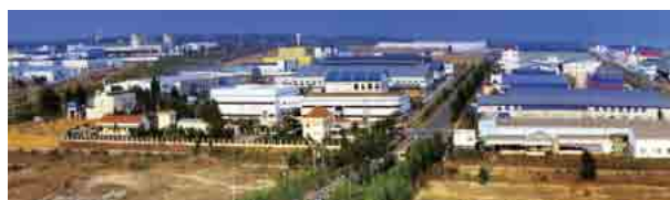
操業中のロンビン工業団地(ベトナム)
