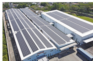
ロッテベトナム ビンズン工場
