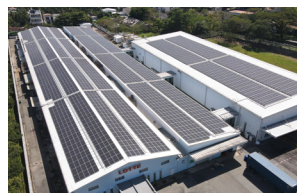
ロッテベトナム ビンズン工場
