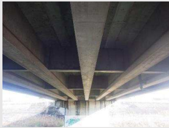
桁・床版(橋梁)の補修・補強
