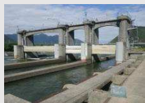
頭首工の補修
