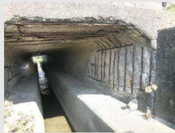
ボックスカルバートの補修・補強
