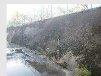
越流堰の補修
