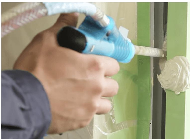
既存枠と新規枠との間にウレタンを充填する「発砲工法」
