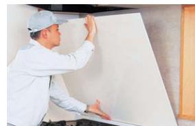
本体の接着用として、接着剤を塗布。ボードを壁に貼り付け固定します。
