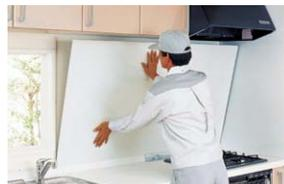
3mm厚タイプは3尺×6尺タイプで9.5kg、3尺×8尺タイプでも約12.3kgと軽く、搬入・取付けが容易です。
