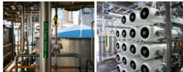
洗浄で使った水を水質に応じた用途で繰り返し使うカスケード利用
