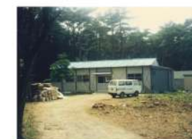
和歌山病院敷地内の一部を借用しプレハブ作業所を建設(現太陽作業所B型事業所)
