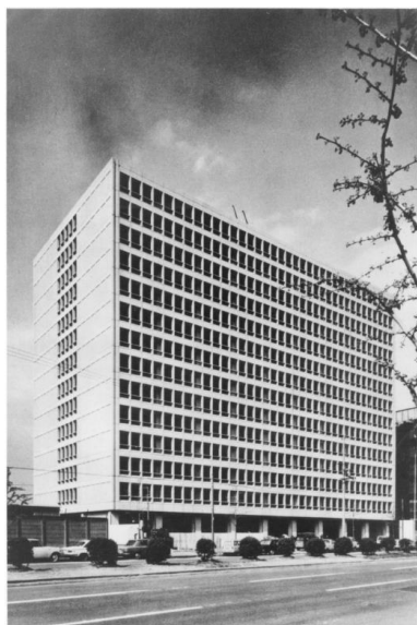
近畿電気通信局（昭和44年2月竣工）
