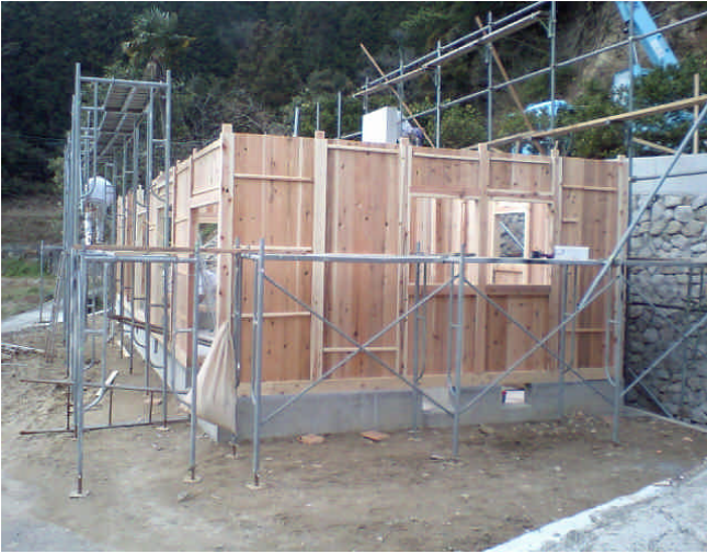
写真2 壁パネル建て込み完了状況
