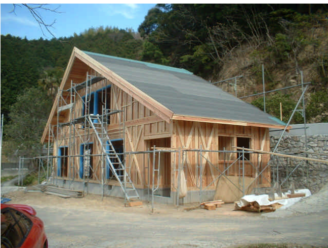
写真3 壁筋交い設置状況
