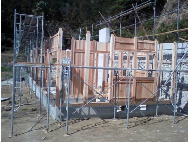
写真1 壁パネル建て込み状況
