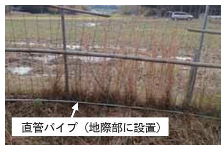
図2 直管パイプによる柵下部の補強
