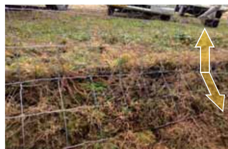
図3 金網による柵下部の補強
