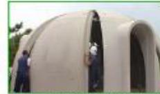
ドームは専用の接着剤で固定します。組立後、日地処理や建長取り付け、内装等の仕上げを行います。基礎や一次設備工事などを終えていれば、1棟であれば、わずか7日間ほどで完成させることができます。
