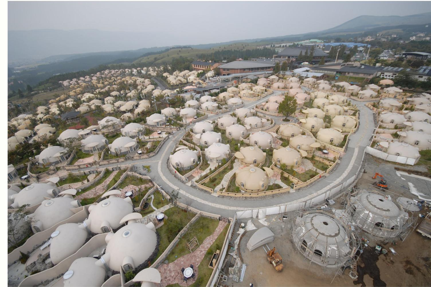
当社が独自の技術で開発した、木・鉄・コンクリートに告ぐ第4の構造材特殊発泡ポリスチレンは、建築物構造体として国土交通大臣認定を取得。さらに、国際特許をも取得しています。
