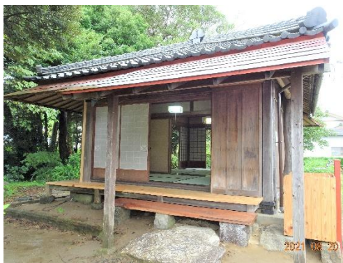
【入日付近(東北側より)】
