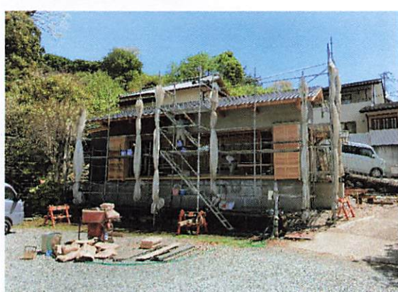
屋根葺き・外壁下地塗り
