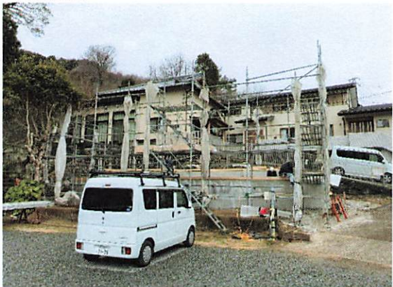
屋根葺き・外壁下地塗り
