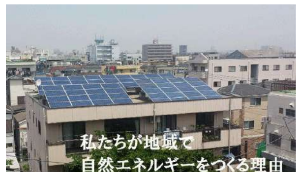
▲市民立発電所「えど・そら」2号機
