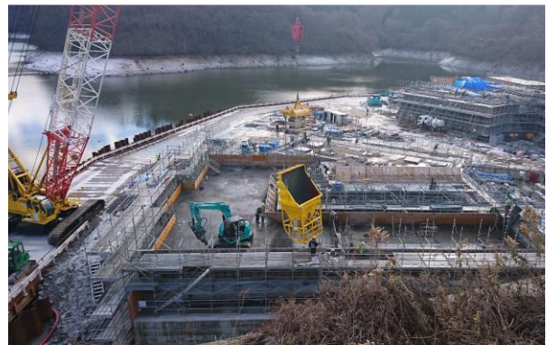
写真－5 水平バケットによる打設状況
