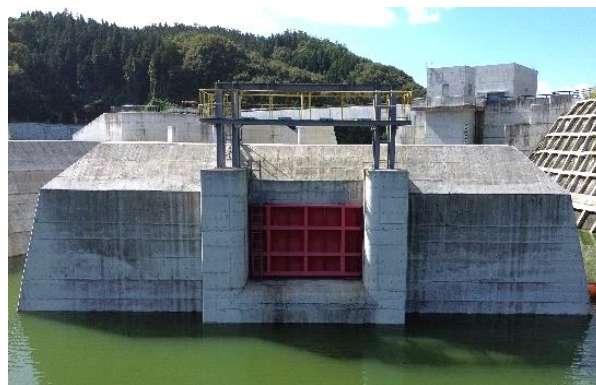
写真－6 仮設ゲート閉鎖状況
