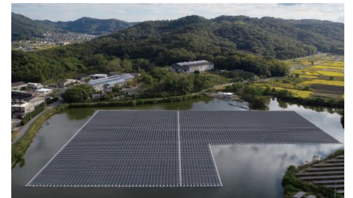
いちご笠岡岩野池ECO発電所
