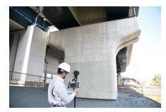
AIひび割れ解析ソリューション
