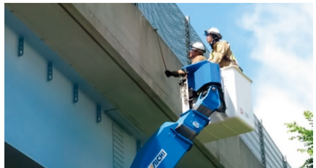
RC 構造の打音検査
