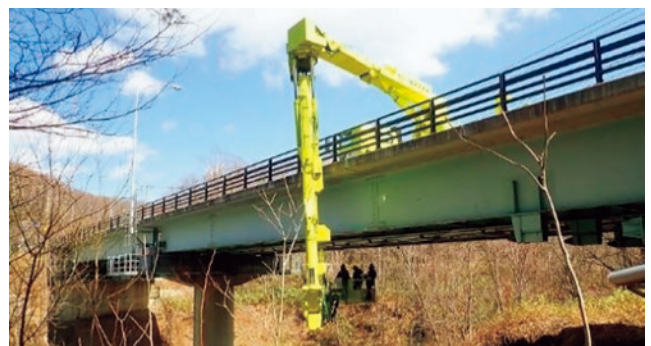
橋梁点検車の活用
