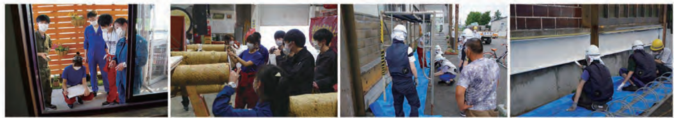
[1巡目] 具体化を検討するため駅舎と行灯とを詳細に実測 [2巡目] 地元工務店さんたちの指導で足場組み、下地塗装
