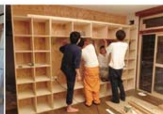
壁面収納施工
