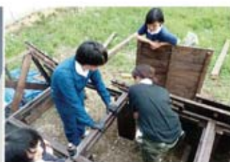
ウッドデッキ施工
