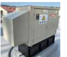
停電など非常事態に備え、発電機を設置
