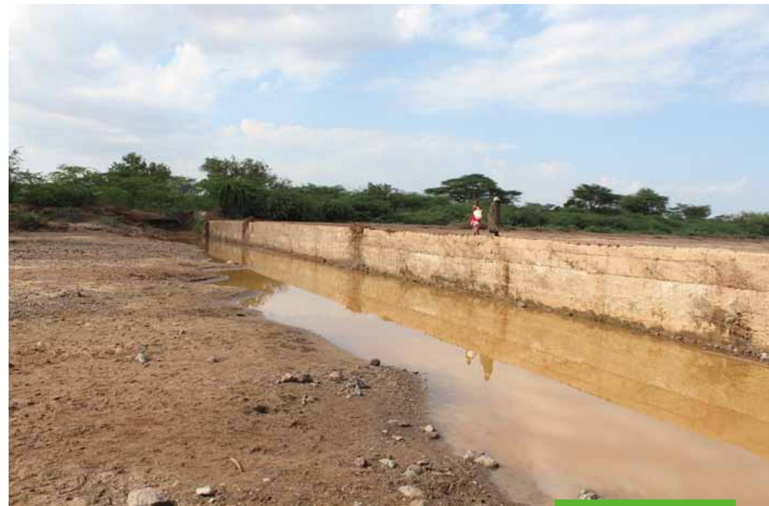
視察に行ったケニアのカクマ難民キャンプの堤防。川の氾濫が激しく、2度の大雨後、堤防は土で埋もれてしまった。
