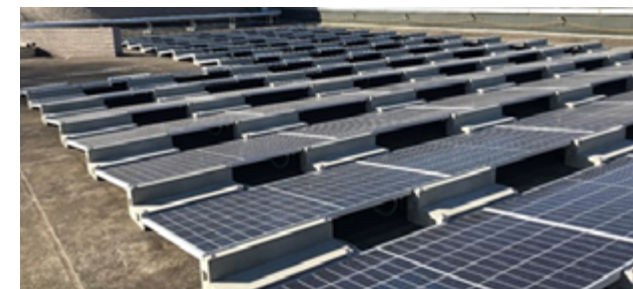
アサヒビール(株)茨城工場見学棟屋上
