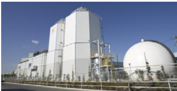
バイオエナジー(株) 城南島工場 外観
