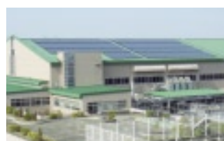
屋根に太陽光発電パネルを設置した博多工場
