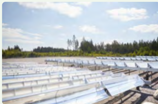
イタリアのパーリ工場における太陽熱集熱器の設置
