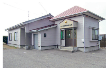
村上市：村上警察署 平林駐在所 建築工事
