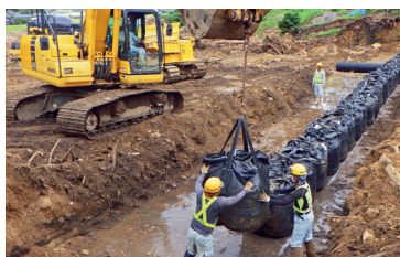
村上市：2022年 豪雨災害復旧工事
