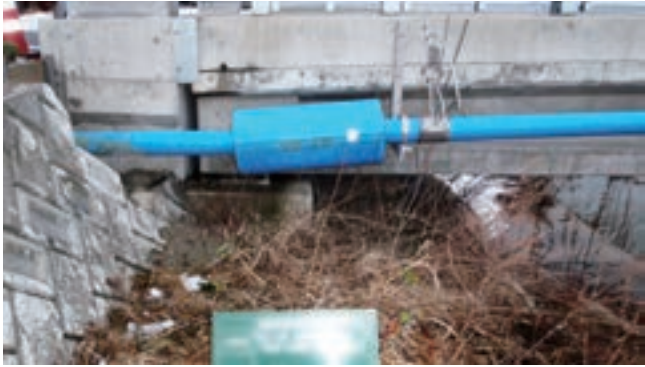
埋設管路不同沈下補修工事(施工前)
