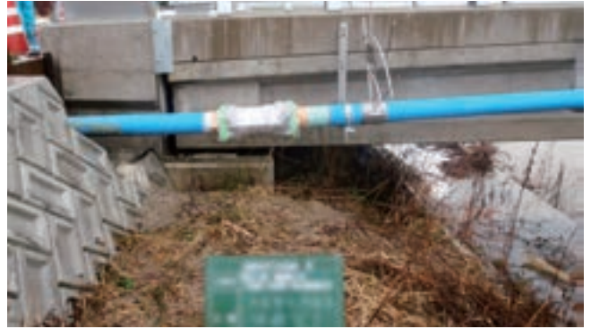
埋設管路不同沈下補修工事(施工後)
