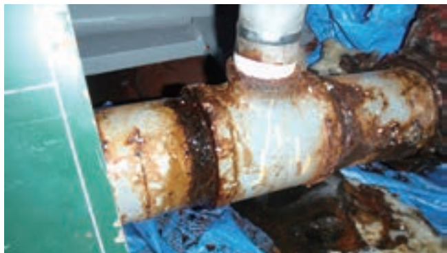
空気弁枝管漏水補修工事(施工前)
