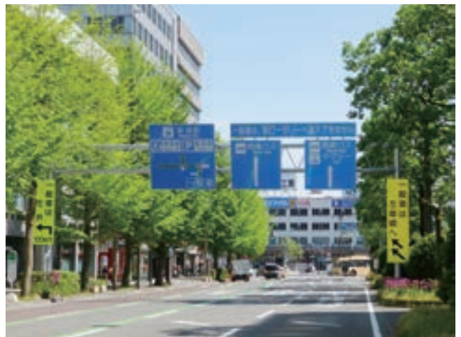
新潟県新潟市 案内標識板門型柱 スパン17.1m
