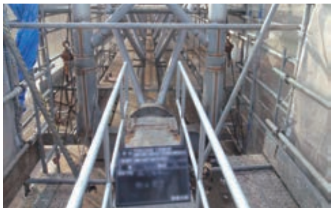
耐震補強工事(橋門補強)
