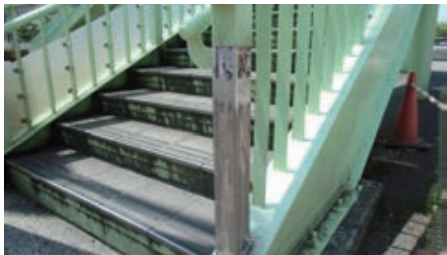
歩道橋階段手摺補修
