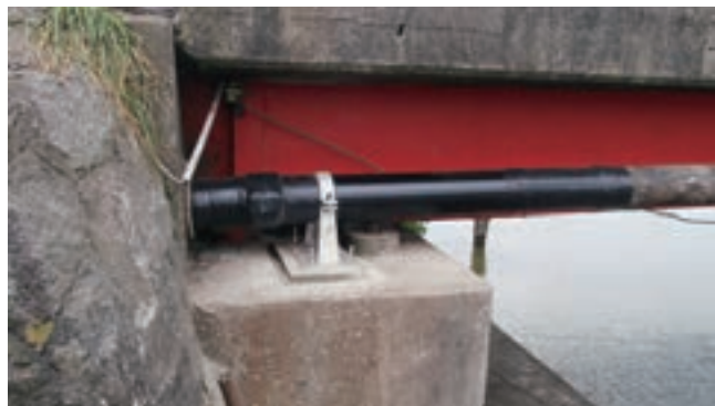
ジョイント部漏水補修工事(施工後)
