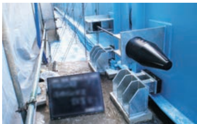
耐震補強工事(落橋防止取付)
