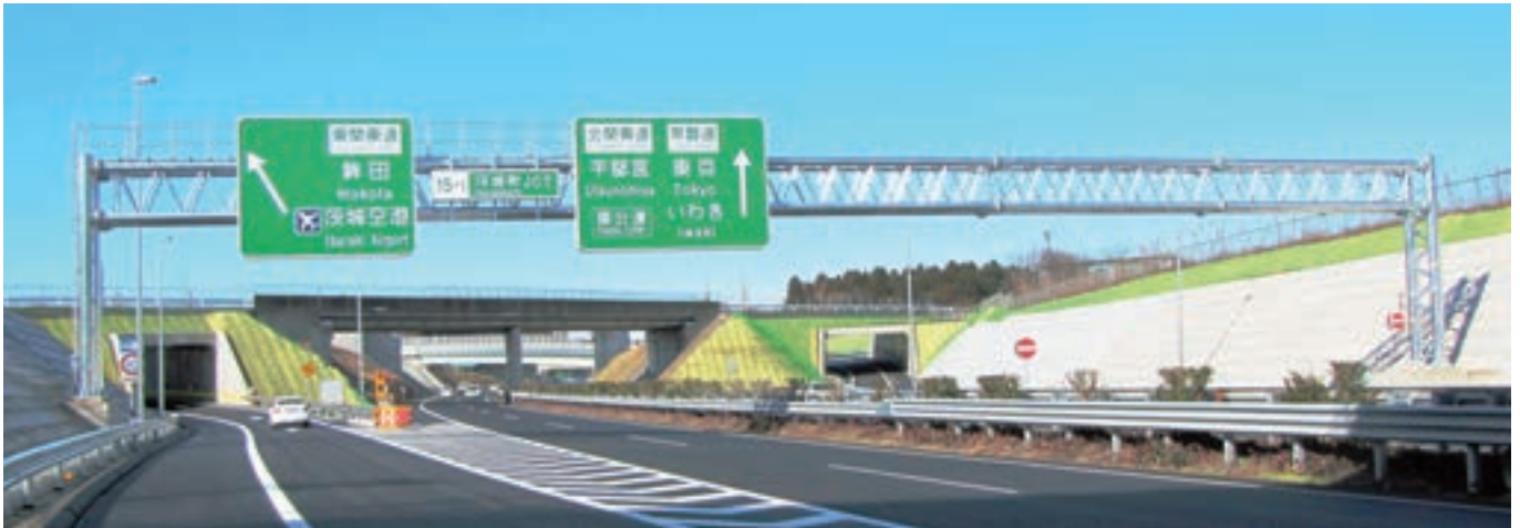
東関東自動車道 茨城県茨城町 案内標識板柱門型柱 スパン43.2m
