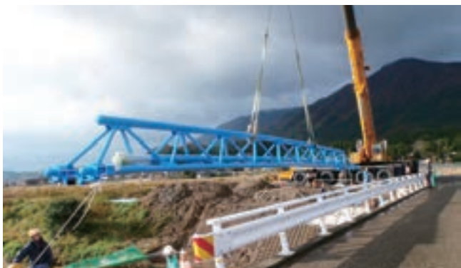
新潟県新潟市 200A 支間24m 設置工事
