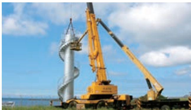
新潟県柏崎市 φ1500 気象鉄塔設置工事
