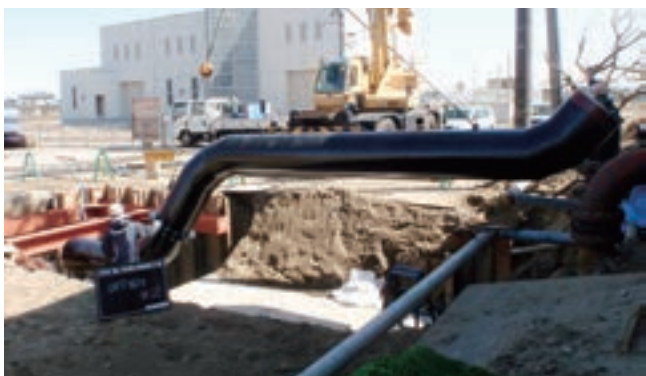
新潟県新潟市 600A 塗覆装鋼管 設置工事
