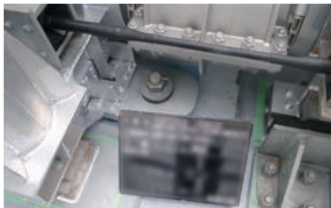
耐震補強工事(落橋防止取付)
