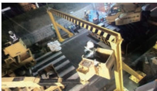
新潟県新潟市 空頭障害構造物設置工事
