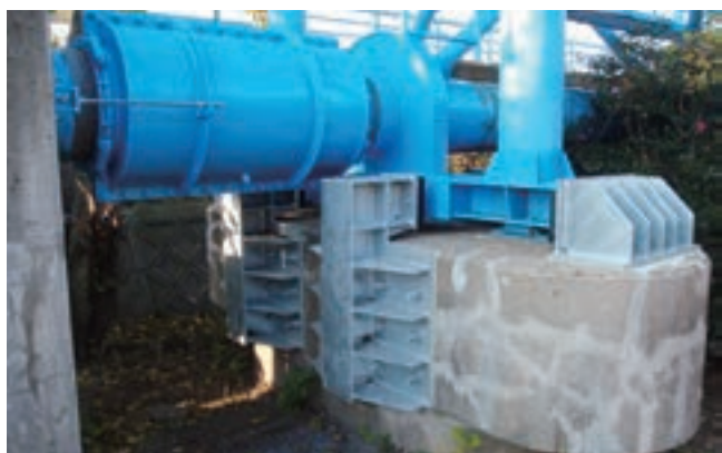
耐震補強工事(落橋防止取付)
