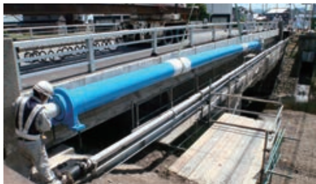
新潟県佐渡市 400A 支間長:14.7m+14.6m 設置工事
