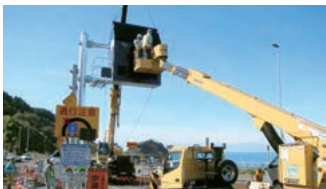
新潟県上越市 トンネル非常警報板F型柱 設置工事
