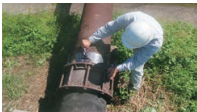
漏水補修工事(施工中)
