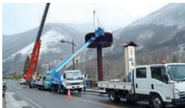
福島県会津若松市 ダム放流警報鉄塔設置工事
