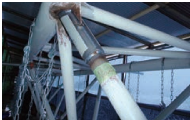
腐食部修繕工事(施工後)
