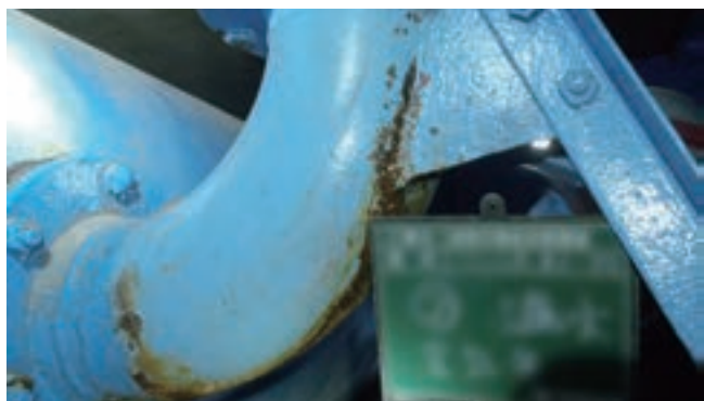
空気弁立上り管漏水補修工事(施工前)
