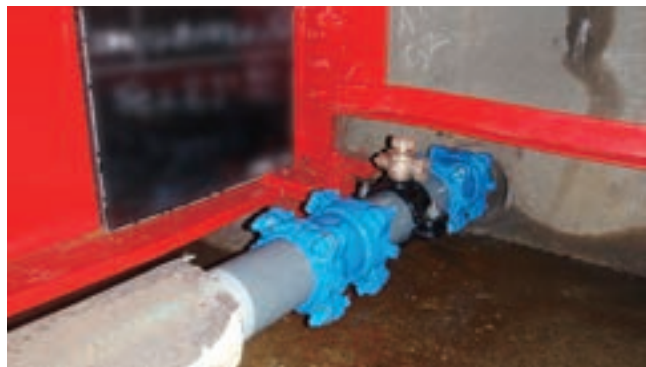
空気弁枝管漏水補修工事(施工後)
