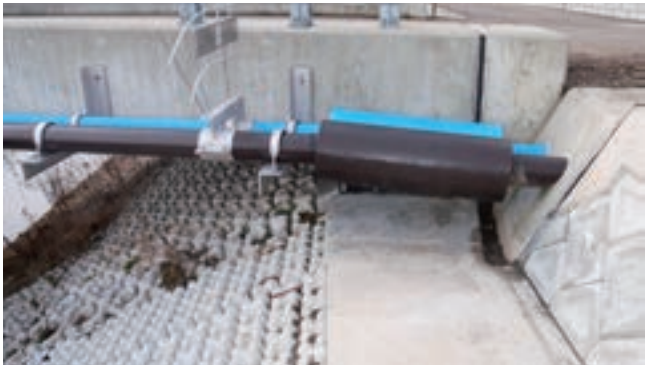
埋設管路不同沈下補修工事(施工前)
