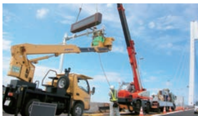
富山県射水市 補助警報表示板設置工事
