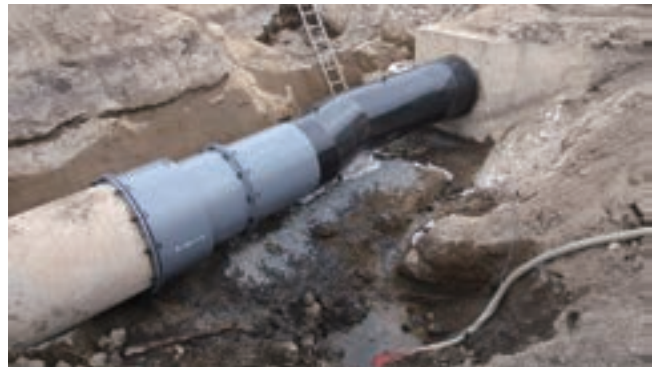
東北地方太平洋沖地震（東日本大震災） 茨城県 管路復旧工事(施工後)
