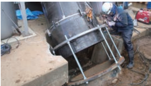
新潟県中越沖地震 新潟県 管路復旧工事(施工中)
