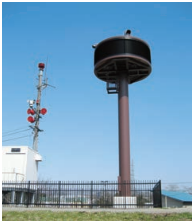
福島県会津若松市 ダム放流警報表示鉄塔 高さ10.0m
