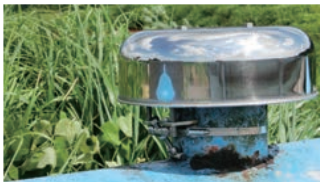
空気弁枝管漏水補修工事(施工後)
