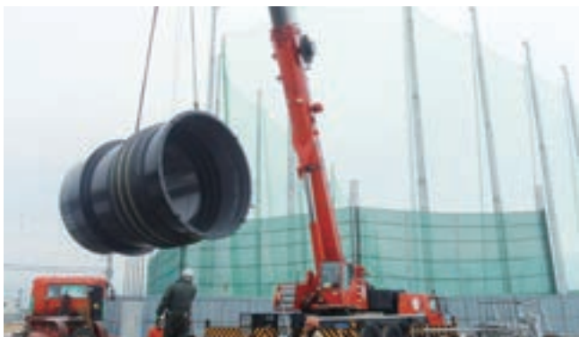
新潟県新潟市 2600A 塗覆装鋼管 設置工事
