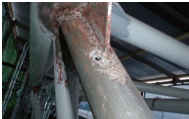
腐食部修繕工事(施工前)
