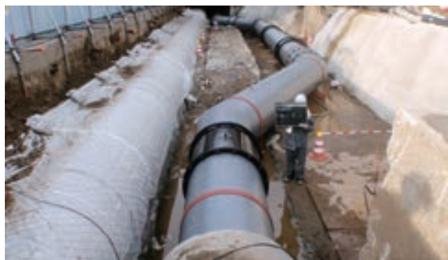
新潟県新潟市 1200A 塗覆装鋼管 設置工事
