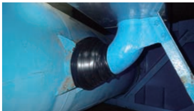
空気弁立上り管漏水補修工事(施工後)
