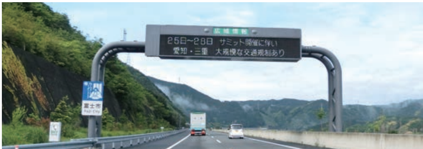
新東名自動車道 静岡県富士市 情報表示板門型柱 スパン15.7m
