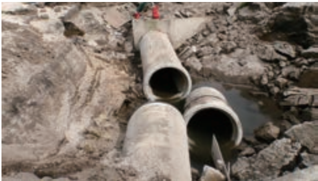
東北地方太平洋沖地震（東日本大震災） 茨城県 管路復旧工事(施工前)
