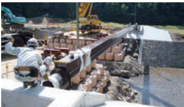
新潟県佐渡市 400A 支間長23.8m 設置工事
