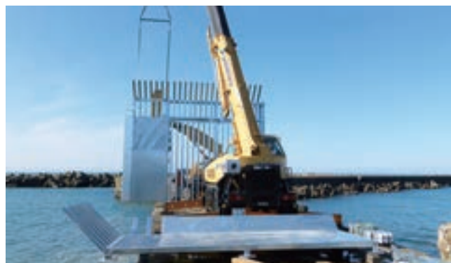
新潟県新潟市 7.7m×5m 防護柵工事
