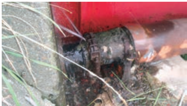
ジョイント部漏水補修工事(施工前)
