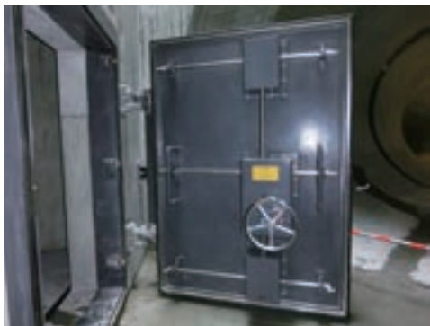
新潟県新潟市 鋼製水密扉 扉寸法:1.7m×2.4m
