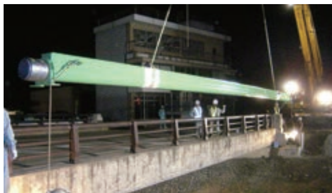
新潟県三条市 300A 支間長17m 設置工事
