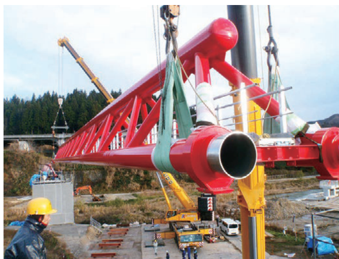
水管橋据付工事
