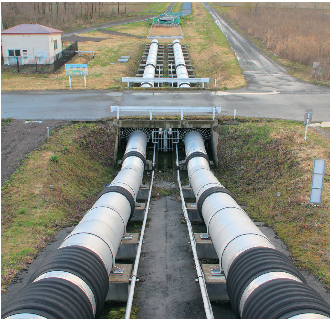
ステンレス鋼管 φ1219.2×9.5t 2連配管
