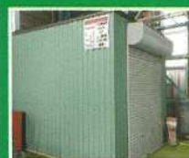
廃PCB保管庫
