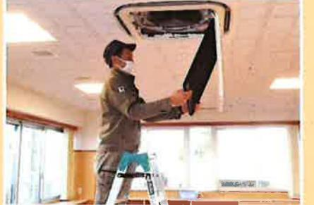
業務内容／各施設の冷暖房機器・ボイラーなどの点検・清掃、水槽の清掃作業、地下油タンクの漏洩検査などのメンテナンス業務を行います。
