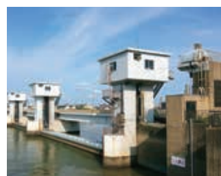
↑ 新潟大堰(新潟県新潟市)
