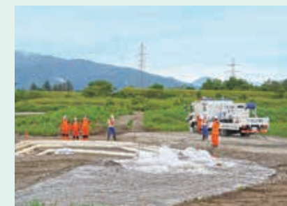
TEC-FORCEによる緊急排水活動訓練
